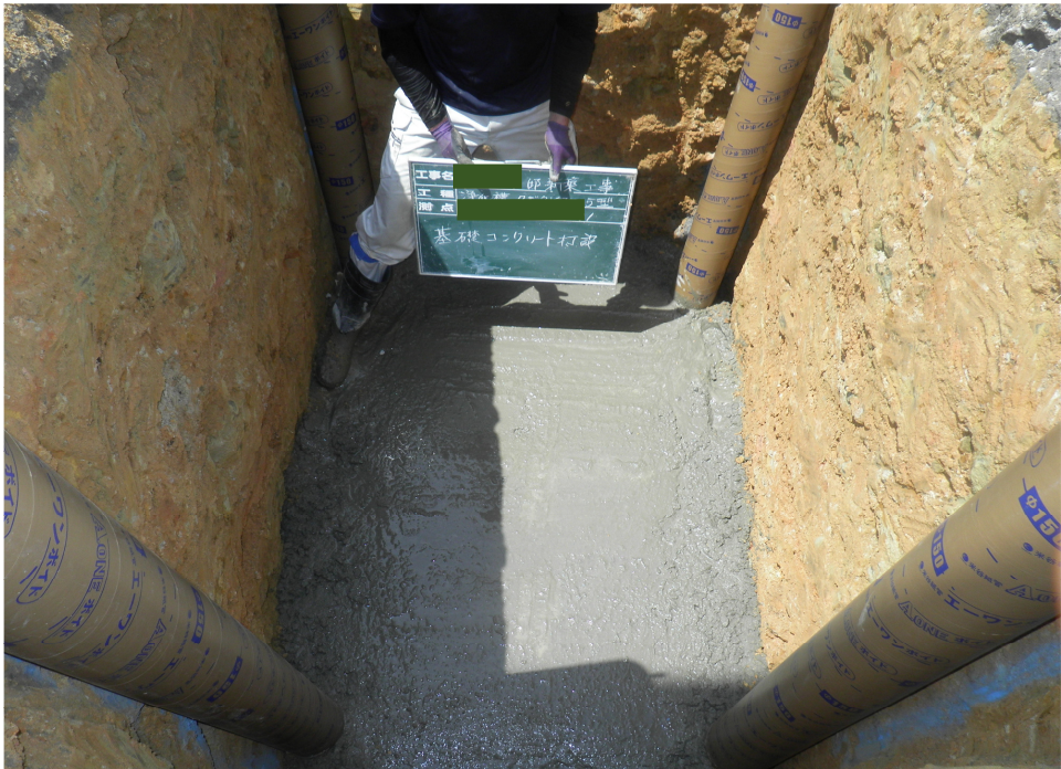
基礎コンクリート打設
